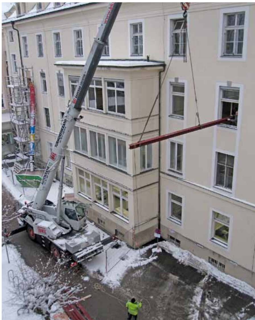
Einbau von Stahlträgern zur Verbesserung der Deckentragfähigkeit
