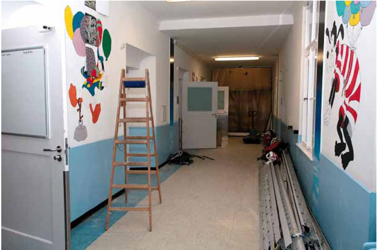
der Gang der Kinderintensivstation vor dem Umbau ...
