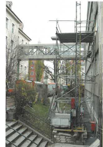
Abb. 1: Außenzugang über Gerüst
