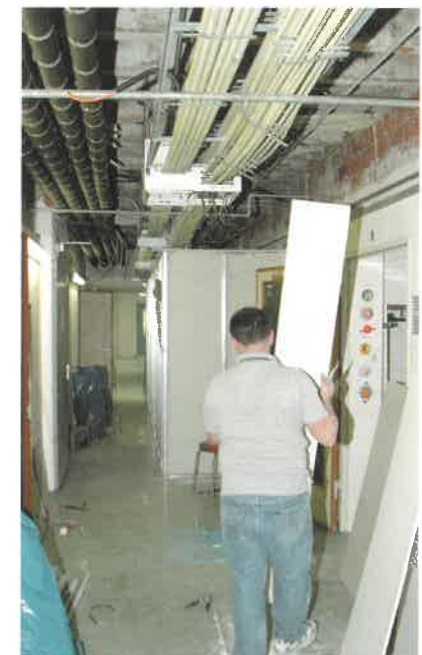
Abb. 2: Baustelle Flur Labortrakt
