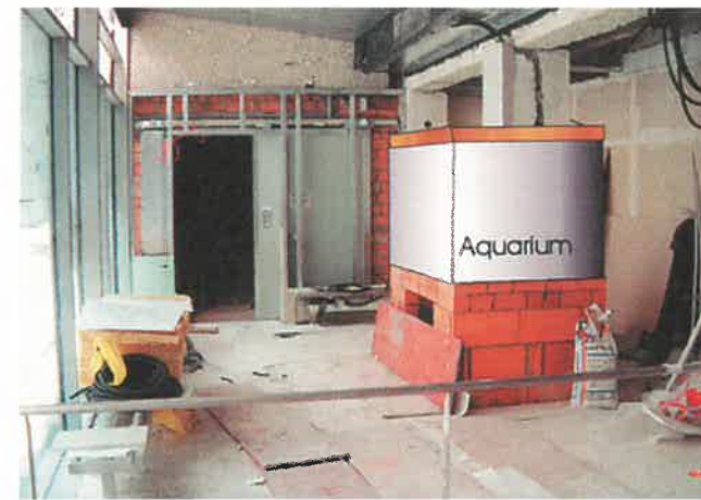
Baustelle der künftigen Eingangshalle mit geplantem Aquarium
