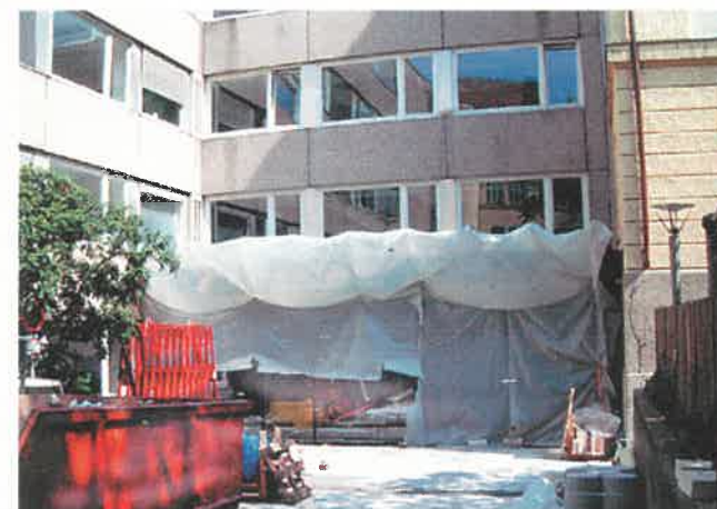
Baustelle der künftigen Eingangshalle mit Krankenanhfahrt
