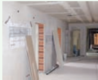
4 Im Bau befindliche Station Intern 5, zentraler Stationsbereich
